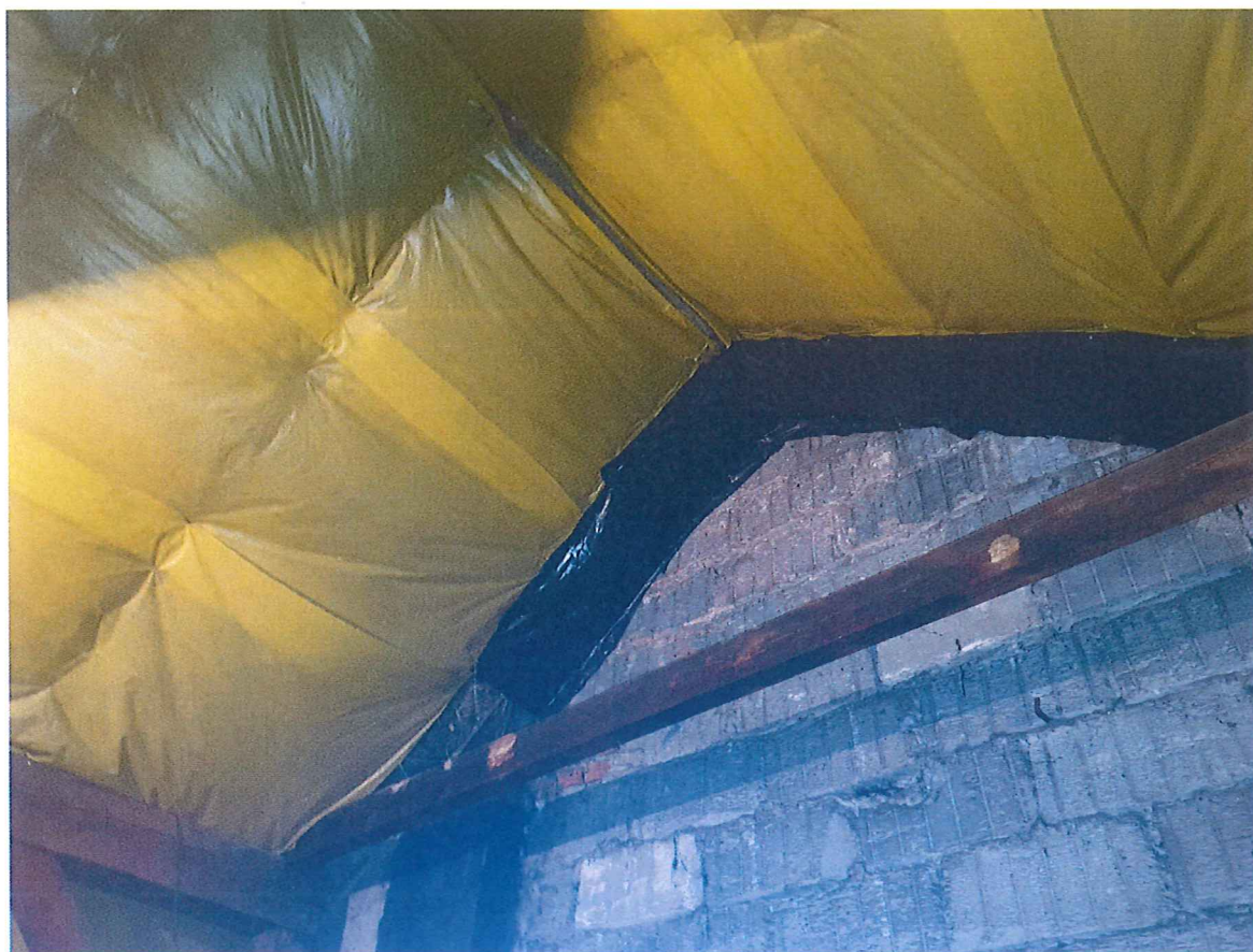
Zdj. nr 3. Doraźne uszczelnienie dachu foli w kalenicy dachu.
