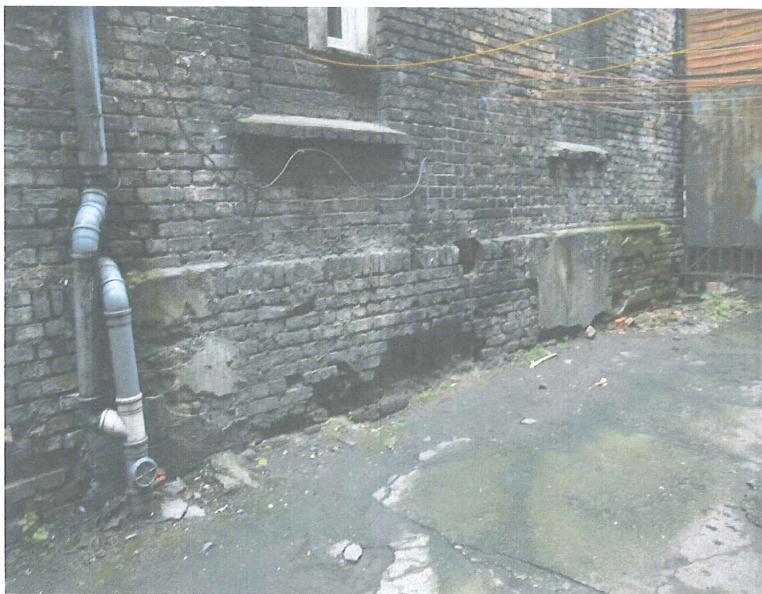
Zdj.15. Ścian od strony podwórza (oficyny).
