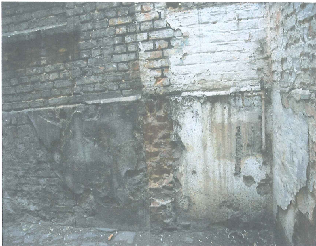
Zdj.17. Ściana od strony podwórza (oficyny).
