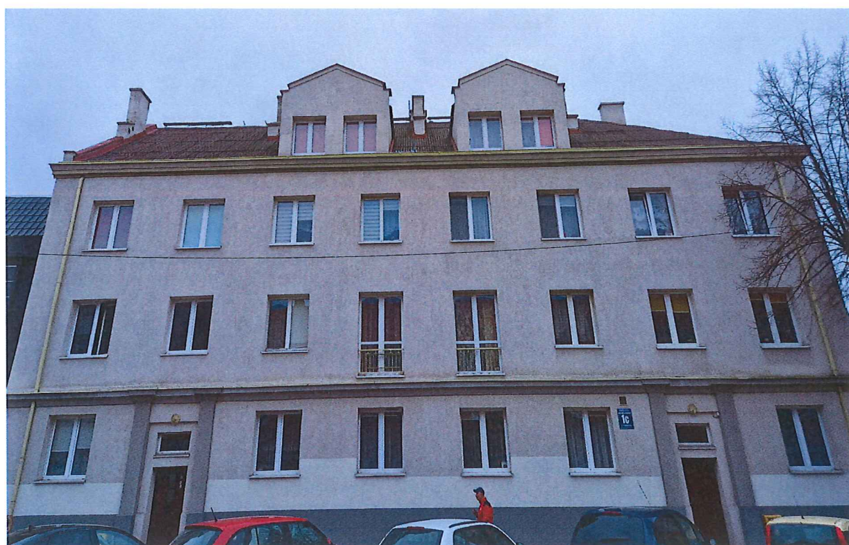
Zdj. nr 9. Rury spustowe odwodnienia dachu
