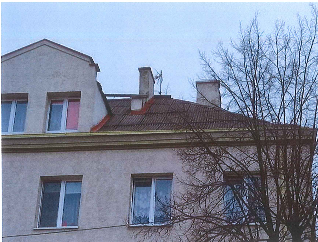
Zdj. nr 3. Dach - widok od strony ul. Poznańskiej cd.
