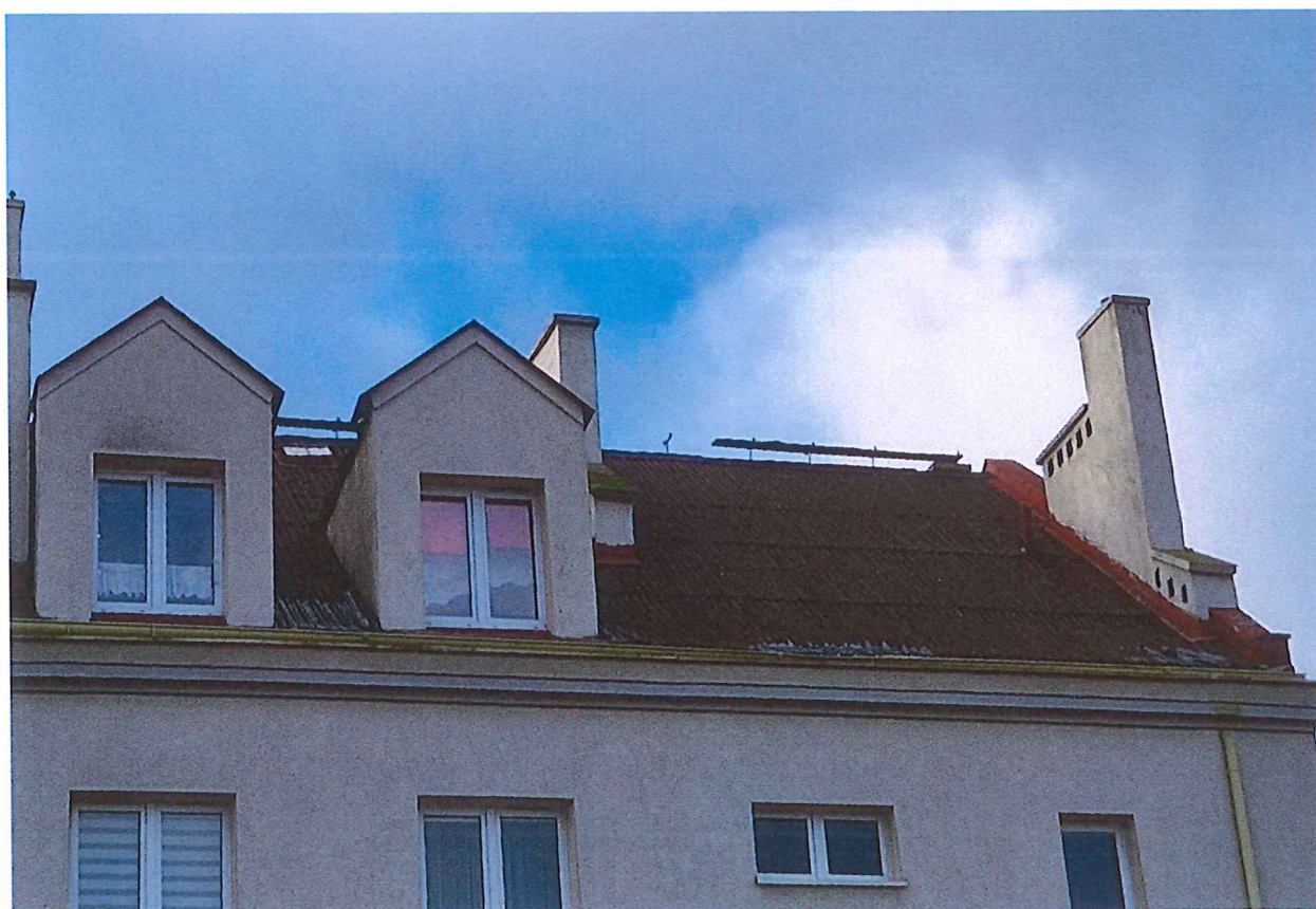
Zdj. nr 6. Dach - widok od strony ul. Rybnickiej cd.
