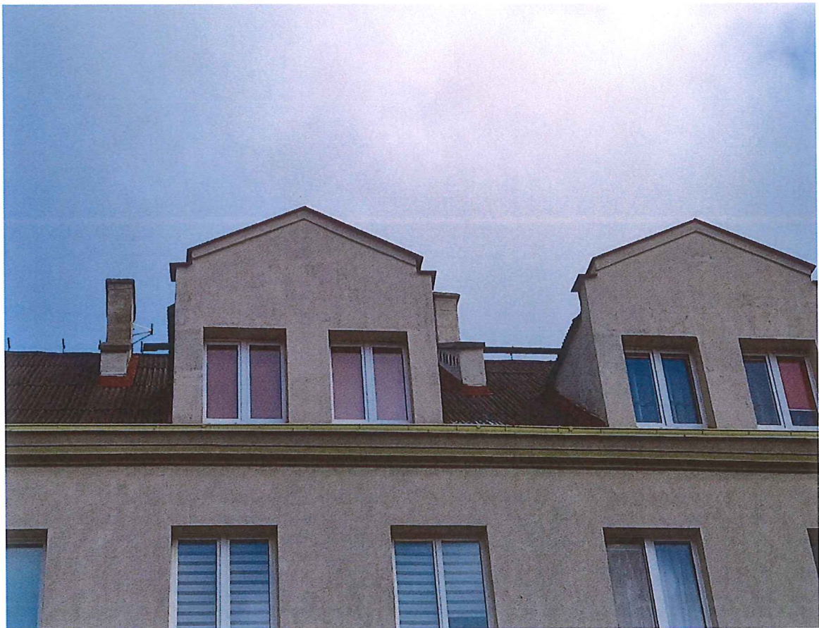
Zdj. nr 2. Dach - widok od strony ul. Poznańskiej cd.
