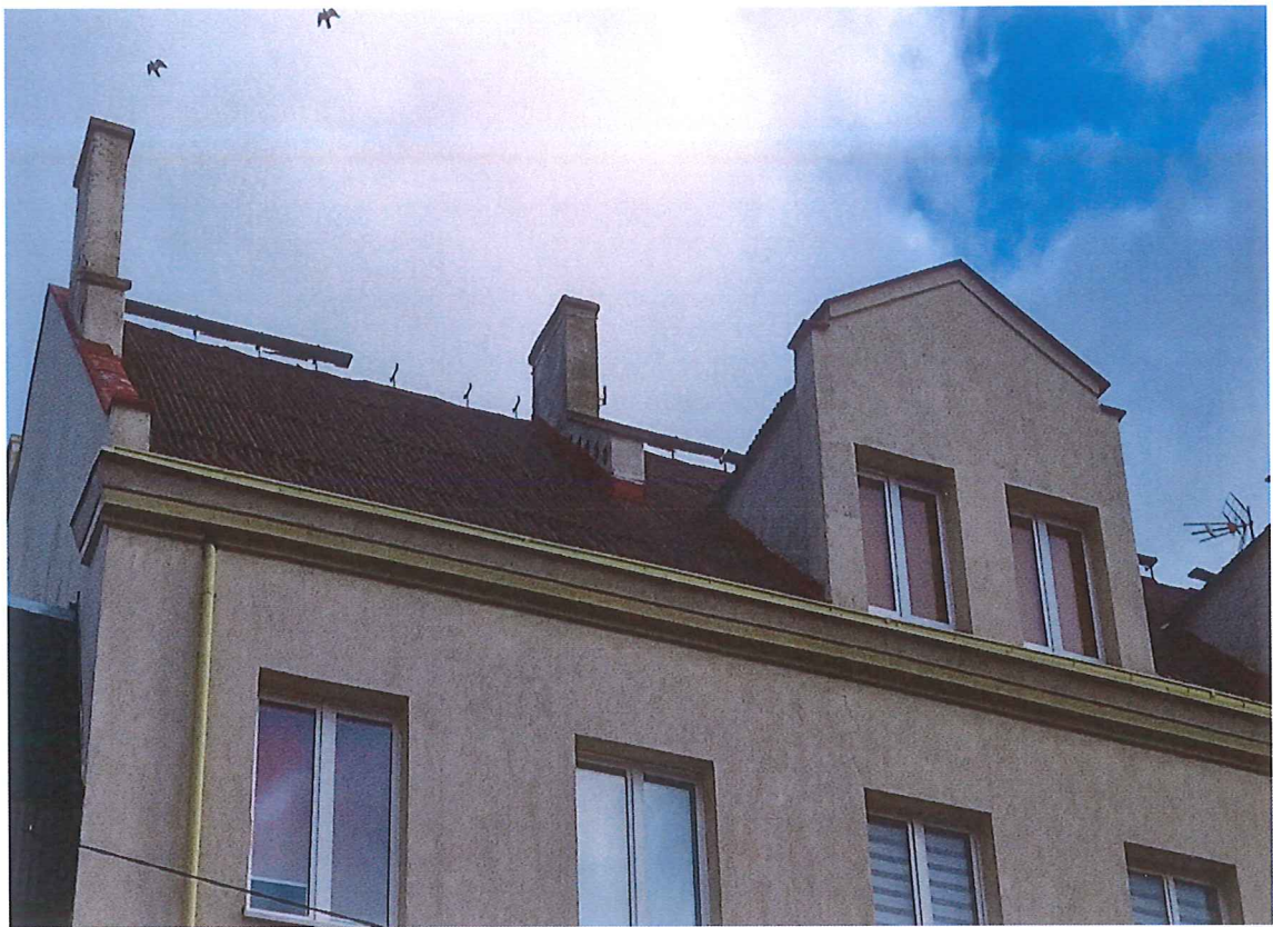
Zdj. nr 1. Dach - widok od strony ul. Poznańskiej.
