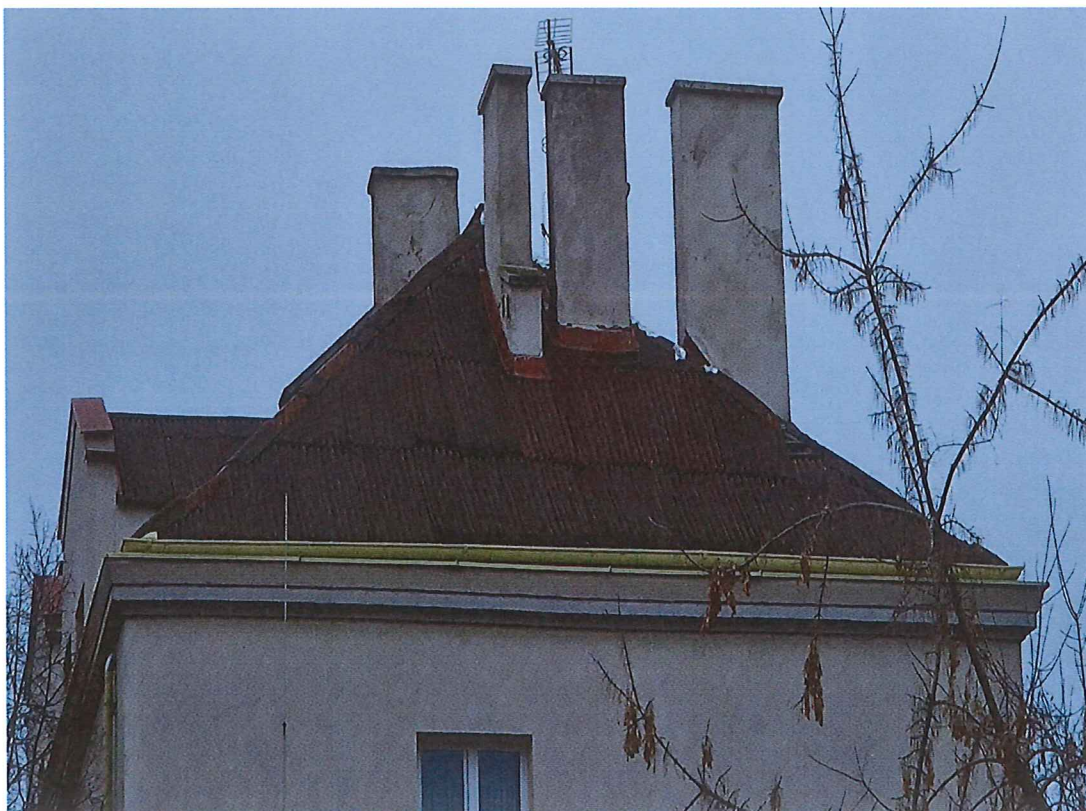
Zdj. nr 4. Dach - widok od strony ul. Kasztelańskiej.
