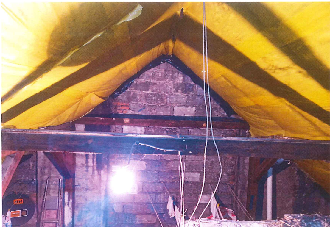
Zdj. nr 11. Dach od strony poddasza, widoczne kleszcze.
