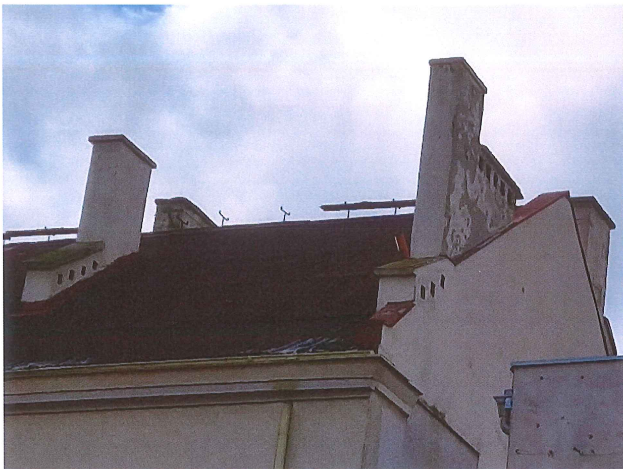
Zdj. nr 8. Dach, kominy od strony ul. Szerokiej.
