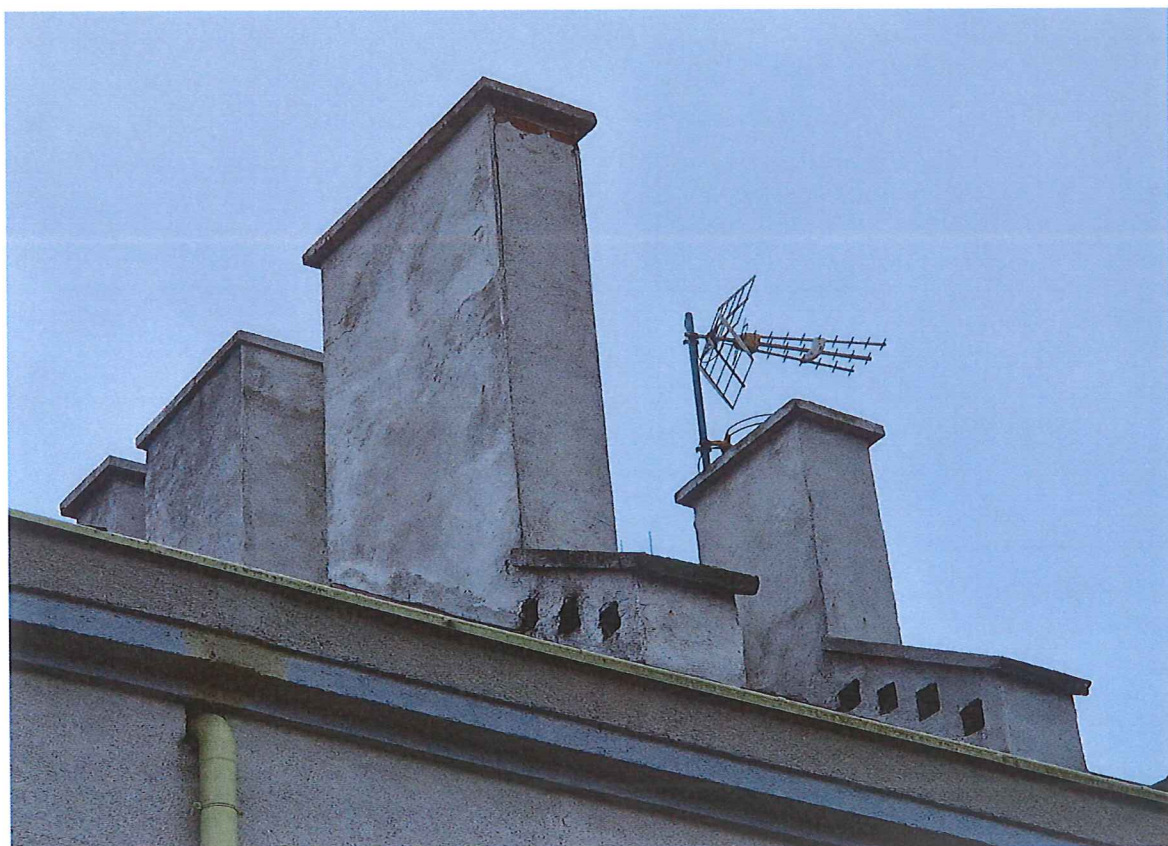
Zdj. nr 7. Dach, kominy od strony ul. Rybnickiej.
