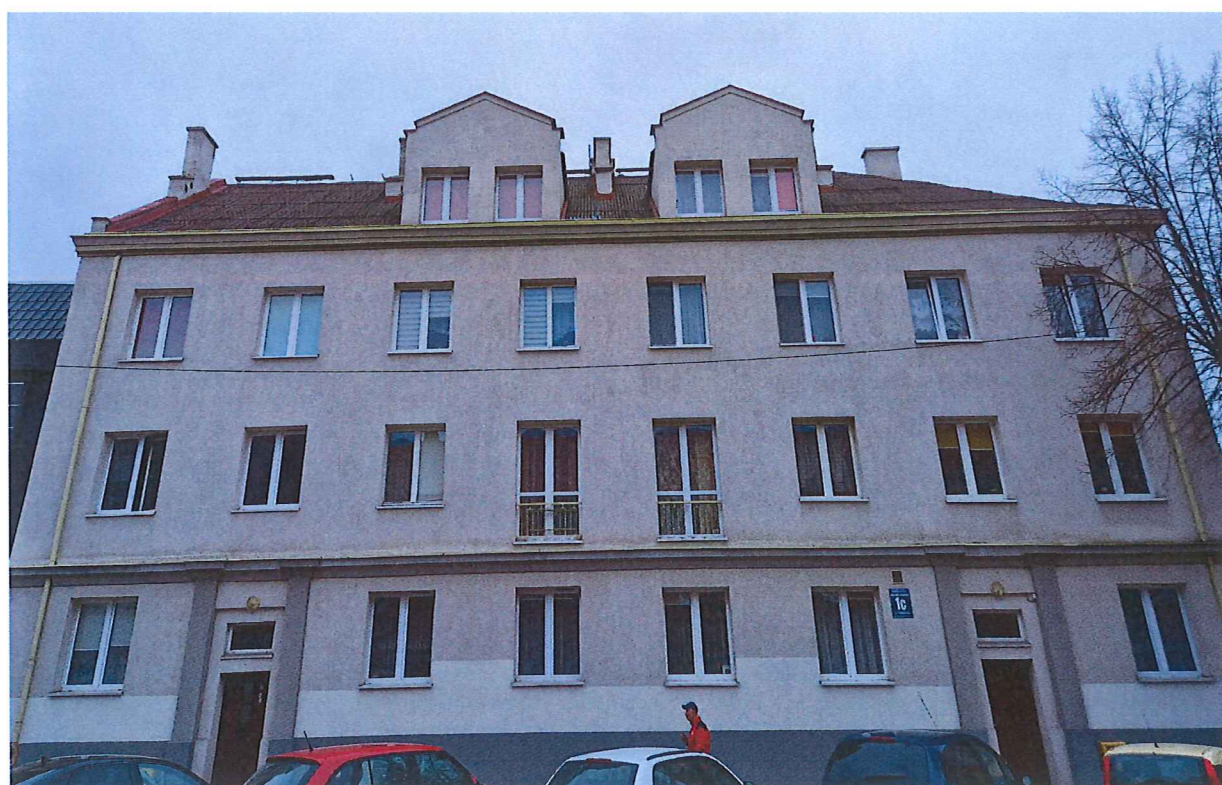
Zdj. nr 9. Rury spustowe odwodnienia dachu
